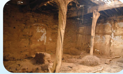
مسجد تاريخي قبل ترميمه
